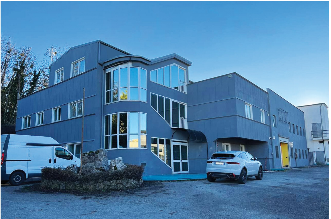
Logistica - Uffici direzionali - Sala riunione Via dell'edilizia, snc - 85100 Potenza
